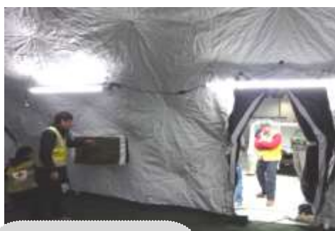
テント内の蛍光灯設置
